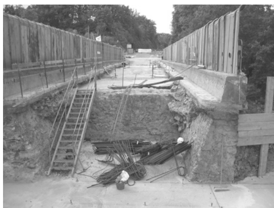
Octobre 2004 : vue du pont en chantier, au premier plan: des restes de fondations datant de l'origine
