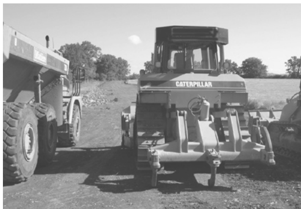
Juin 2004 : début des travaux sur la nouvelle route de desserte du Parc d'activités et desservant Puy-blanc et Reyrevignes.
