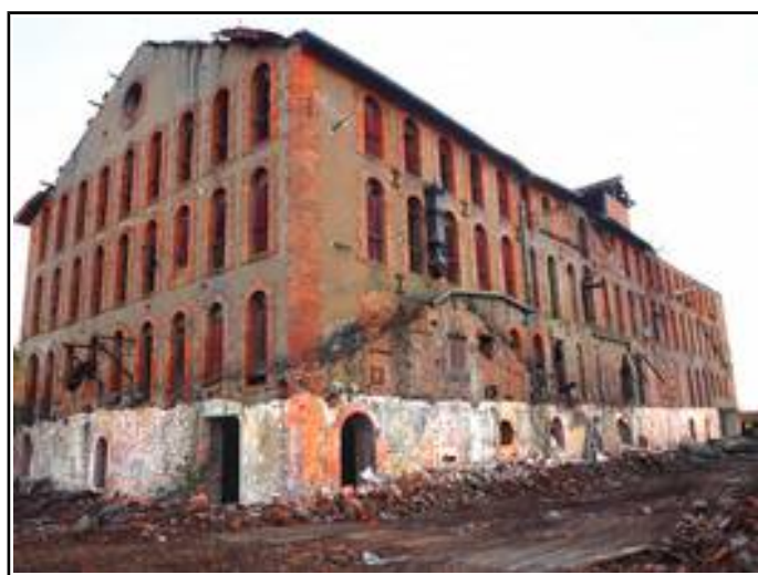
façade nord- est
